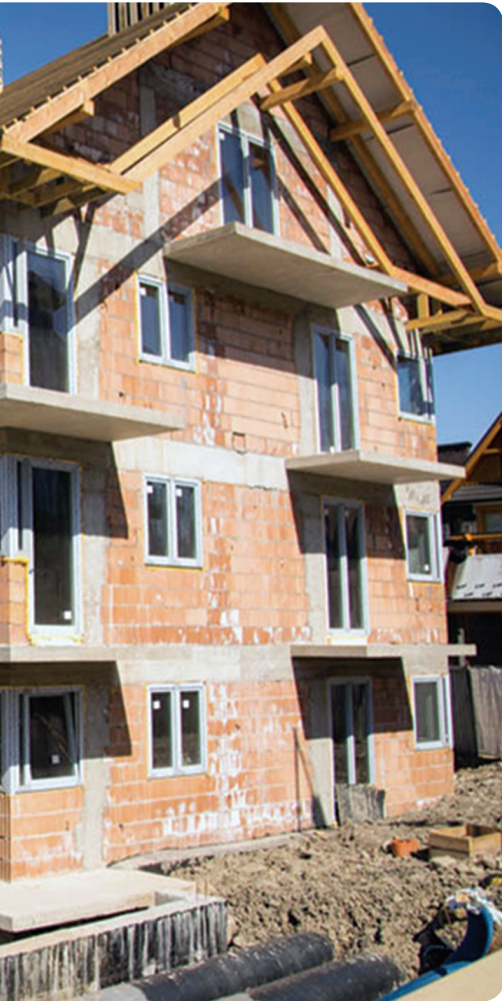
▼ Budynek komunalny przy ul. Kamieniec
