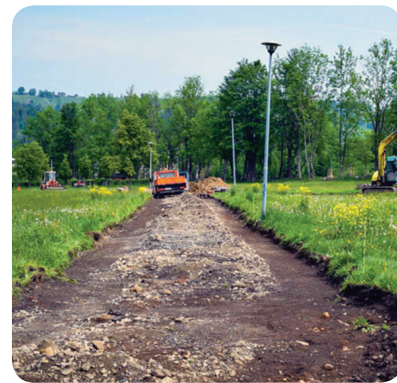
▶ Remont alejek na Górnej Równi Krupowej
