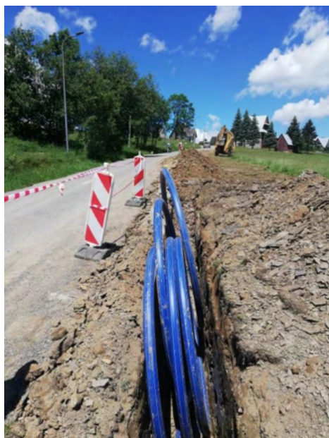
Fot. 5 Budowa wodociągu Gawlaki
