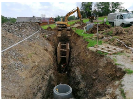
Fot. 1 Budowa kanalizacji na Gawlakach
