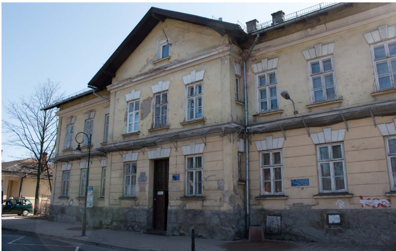
Rys. III.2.35 Zamieszkane budynki zdekapitalizowanego zabytkowego kompleksu dworcowego
